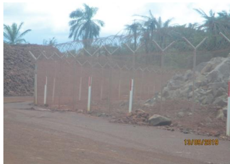
Clôture du site u port de Cap Verga.
