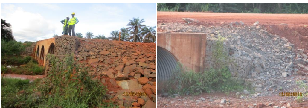
Mesures anti érosives sur les abords des buses.
