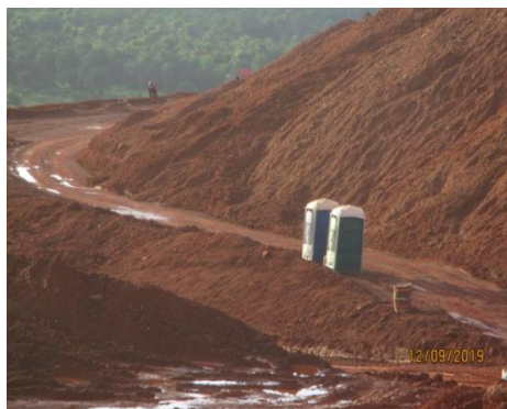
Des toilettes sur le site.
