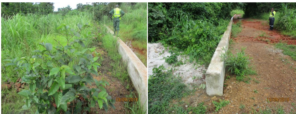
Le soubassement pour protéger la tête de source.
