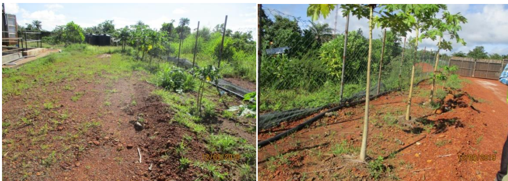
Clôture de grillage autour de la station de traitement.
